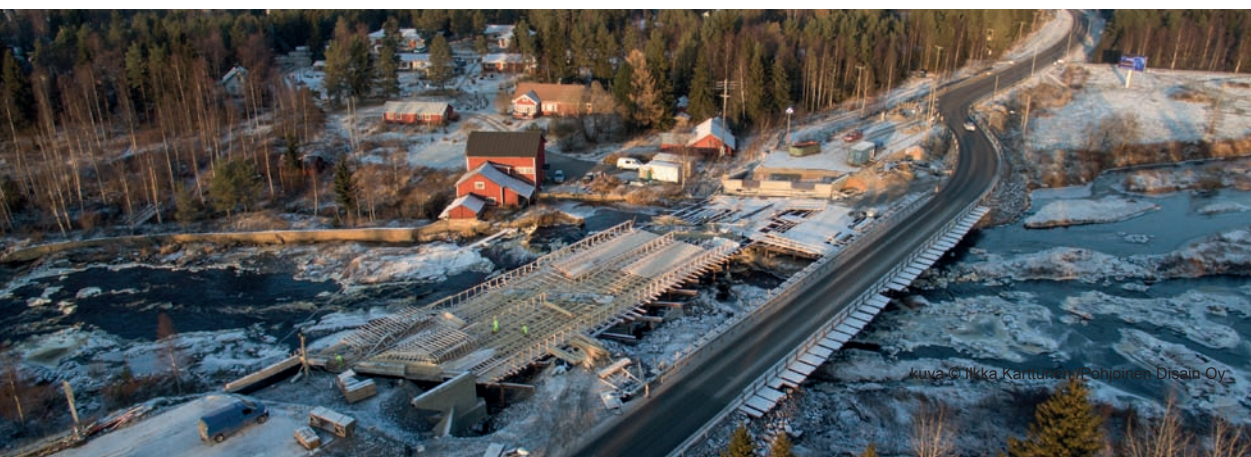
Pyhäjoen ylittävä silta rakenteilla
